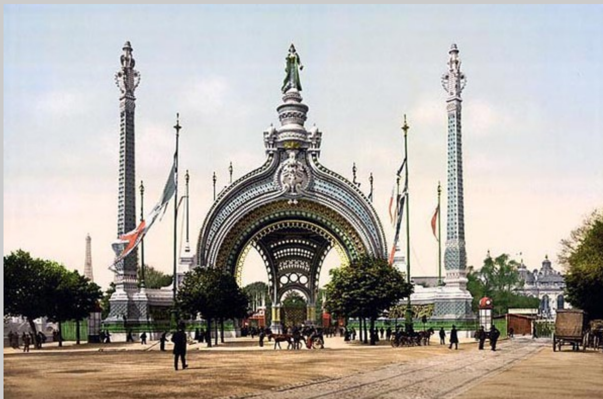
Porte monumentale de Binet
