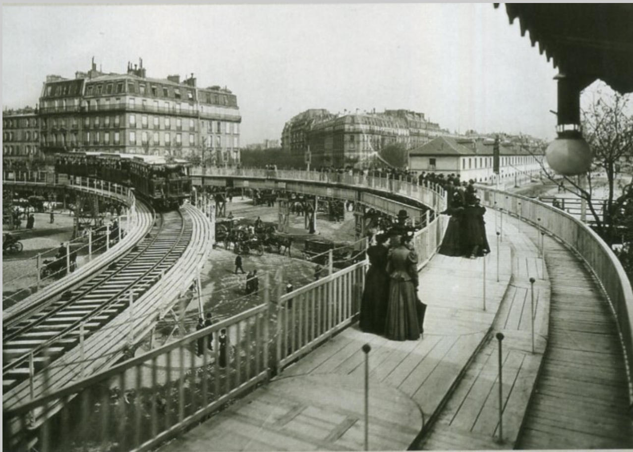
Chemin de fer électrique et trottoir roulant
